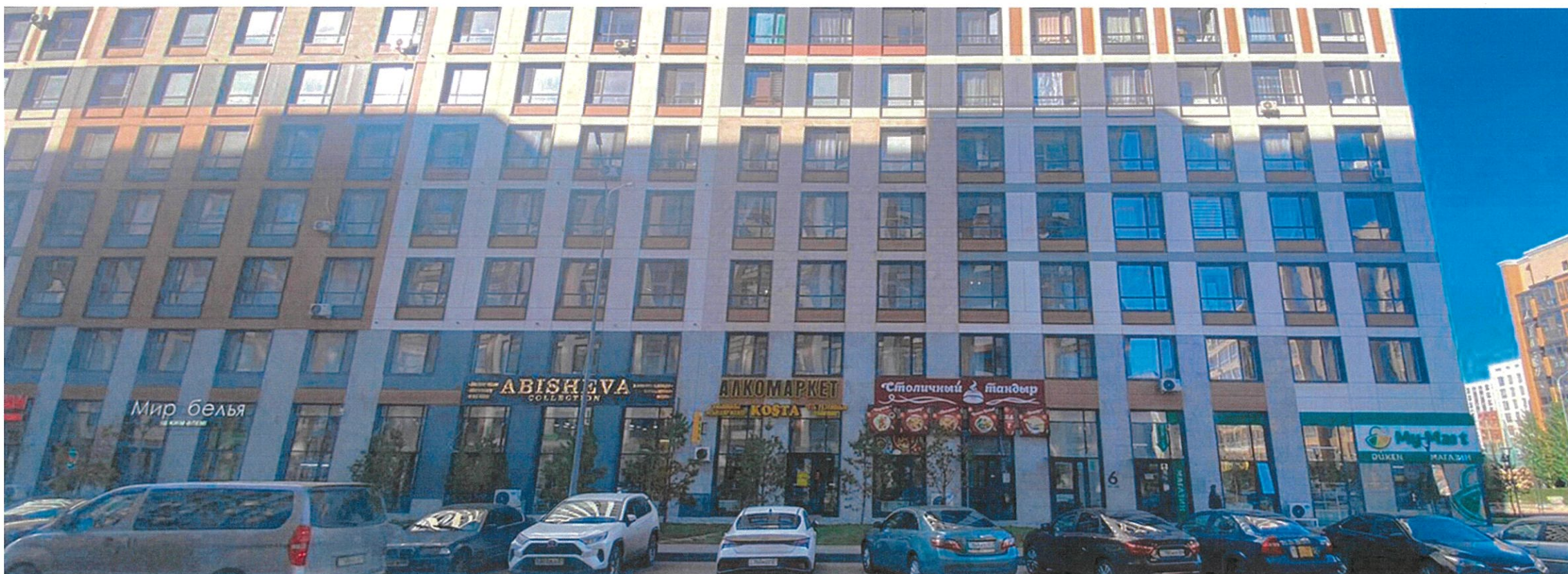
Южный фасад здания по ул. Акселеу Сейдимбек
