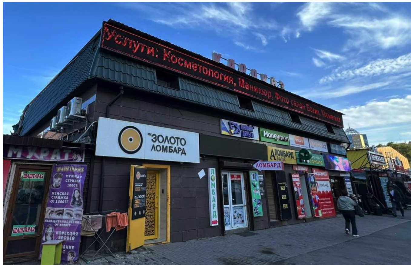
Фасад здания со стороны ул. Уалиханова
