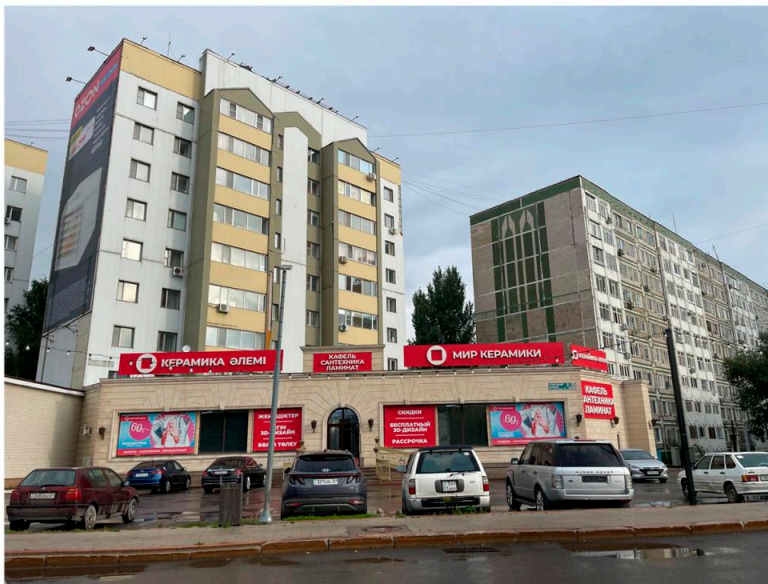
Северный фасад здания по улице Бараев.
