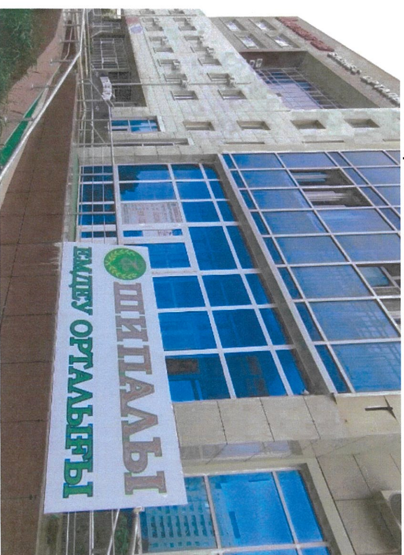
Восточный фасад здания
