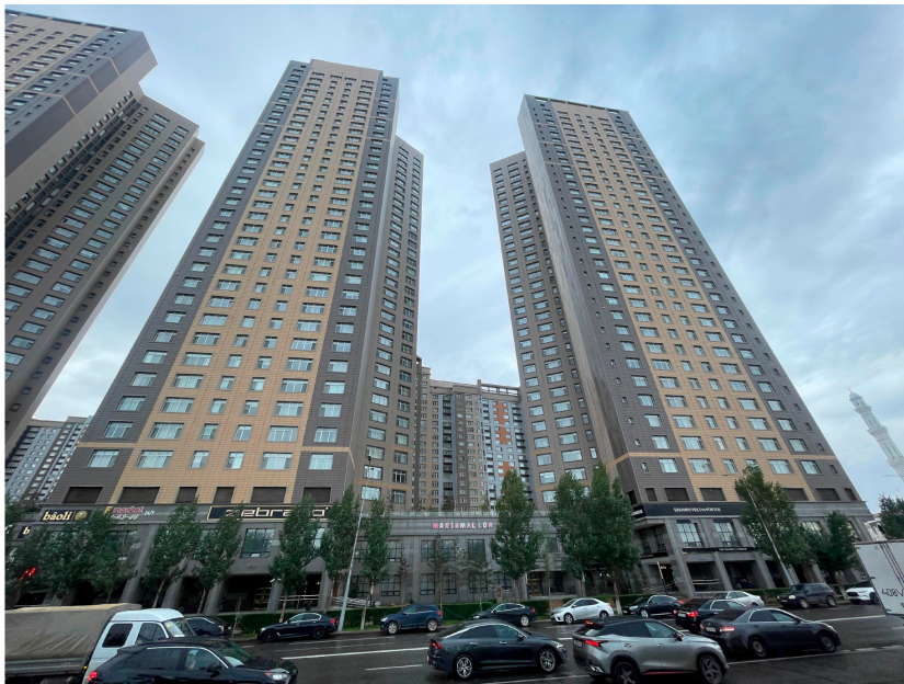
Юго-западный фасад по улице А. Байтурсынулы
