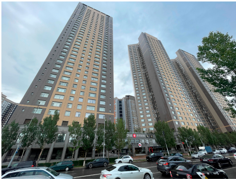
Юго-западный фасад по улице А. Байтурсынулы
