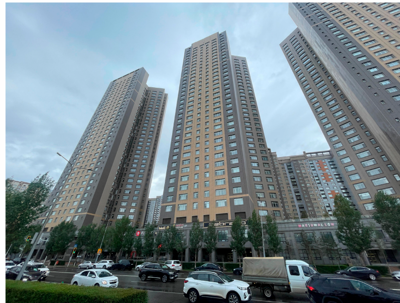
Юго-западный фасад по улице А. Байтурсынулы
