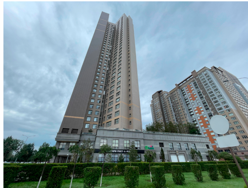
Восточный фасад по проспекту Тауелсиздик
